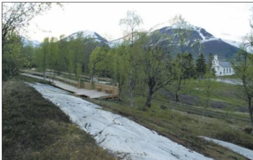
TREVANDRINGEN MED SITTEBENKER; På Kirkelyfjell. Arbeidet er ikke helt ferdig på dette bildet som er tatt sist i mai. Til høsten starter arbeidet med byggetrinn 2 på feltet.
